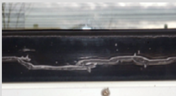
Ursache: Chemikalienangriff; Folge: Anlösen der Oberfläche © GEALAN Fenster-Systeme GmbH
